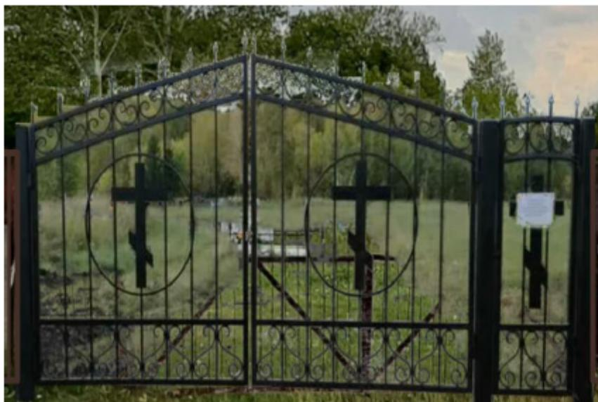
*Материалы: Профилированная труба различного сечения*
